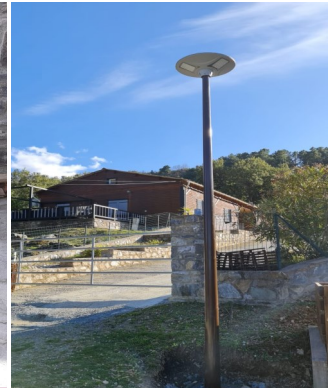
Eclairage solaire au lieu-dit Campitellu
